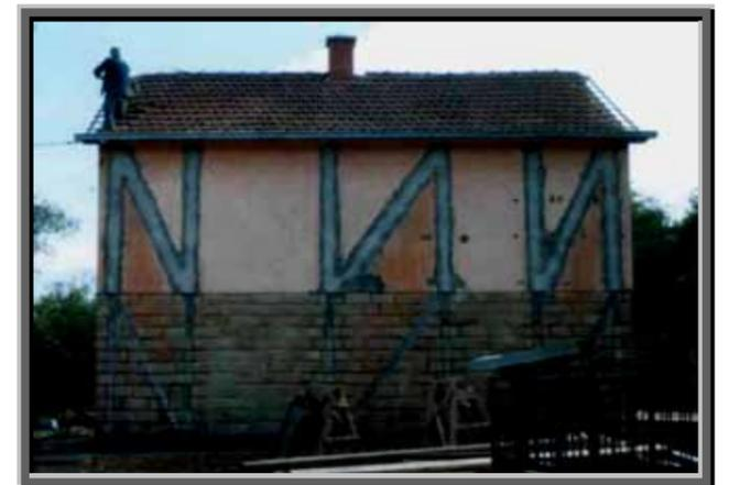
**SYSTEM DC 90 - TYPES OF VERTICAL BRACING**
