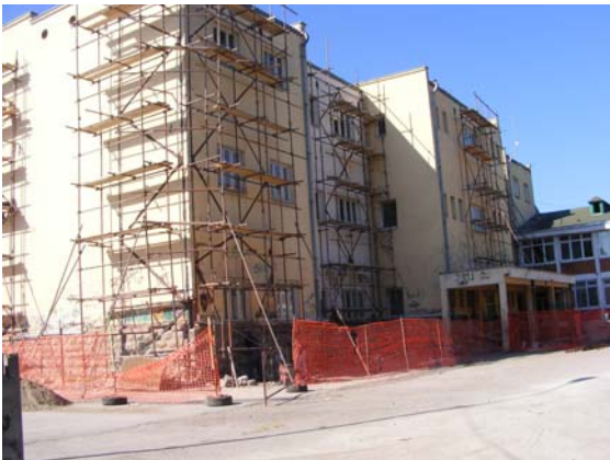
Фасада ОШ Д Туцовић
