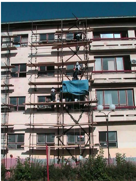
Фасада Гимназије у току попуњавања иллицева ситнозрним бетоном
