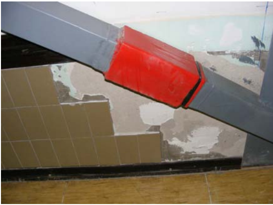
Амортизер 1100 КН/5мм. на Гимназији ван равни зида
