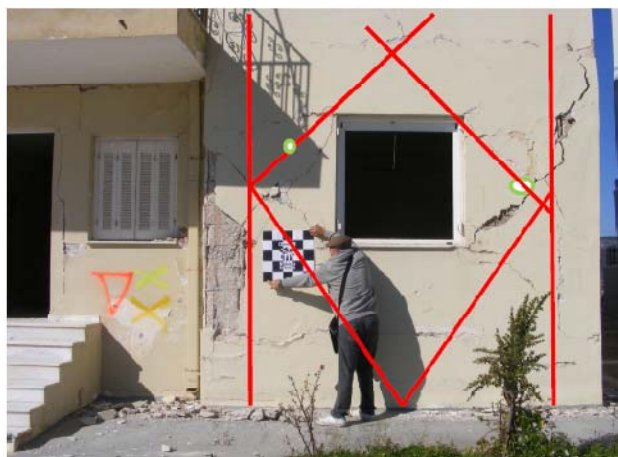
Tehnologija ojačanja pravoslavnih crkava primenom Dampera DC90, slika levo. Jako oštećen objekat za socijalno stanovanje može se sačuvati tehnologijom vertikalnih ukrućenja sa čeličnim histerezisnim Amortizerima Sistema DC90, slika desno
